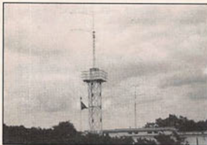
... et les antennes du radio-club FF1FFW.
