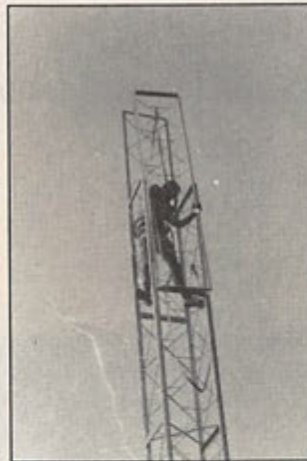
Montage d'un panneau.
