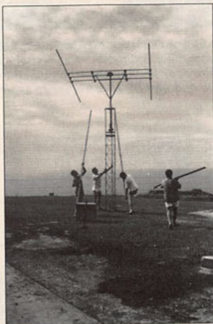
Montage de la structure support d'antennes.
