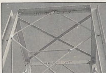
Détail des croisillons anti-torsion.
