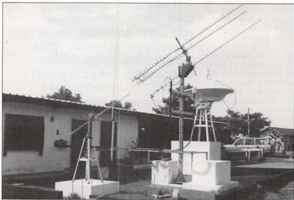
Vue d'ensemble du parc antennes et de la station TR8BL.
