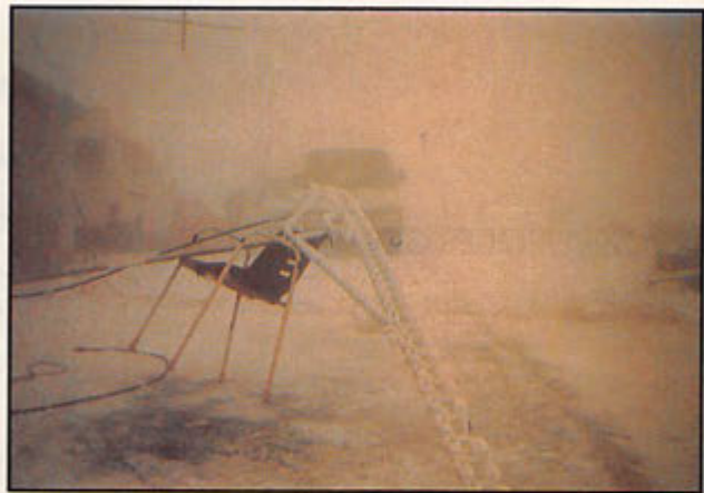
L'antenne 1255 au démontage. Au 1er plan, on voit un élément dégagé du givre. Le reste en dit long sur le temps qu'il fait ! (Hi).
