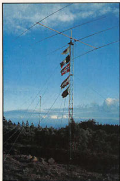
Antenne 20 m terminée.
