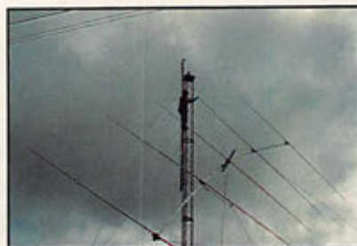
Montage de la Yagi 5 él. 15 m.
