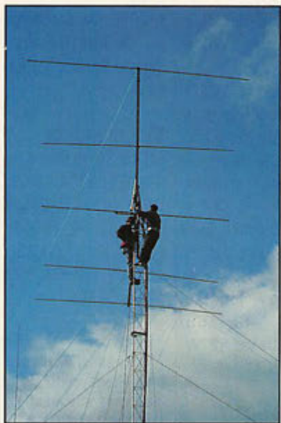
Montage de la Yagi 5 él. 10 m (FB53 sans traps).
