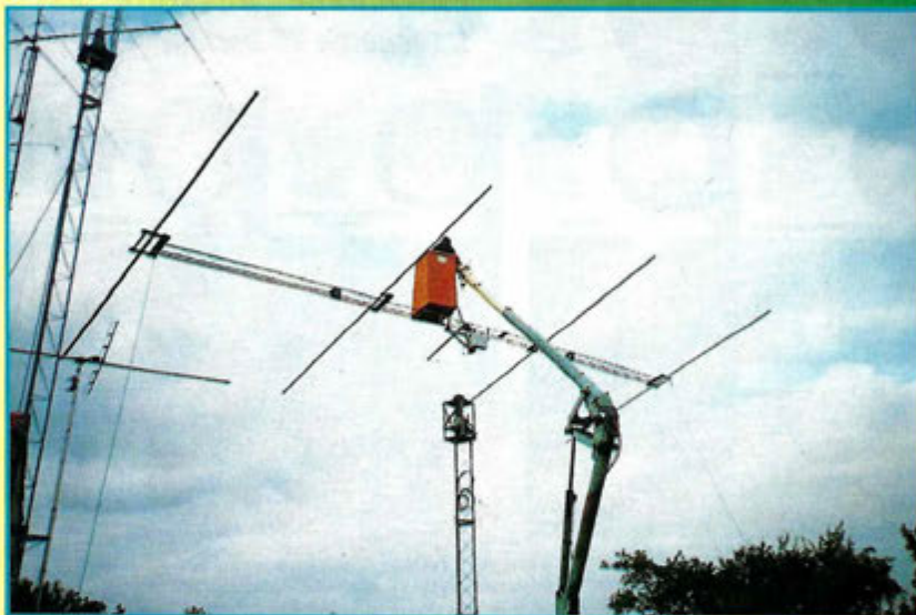
Montage de la poutre, F1NZK aux commandes
