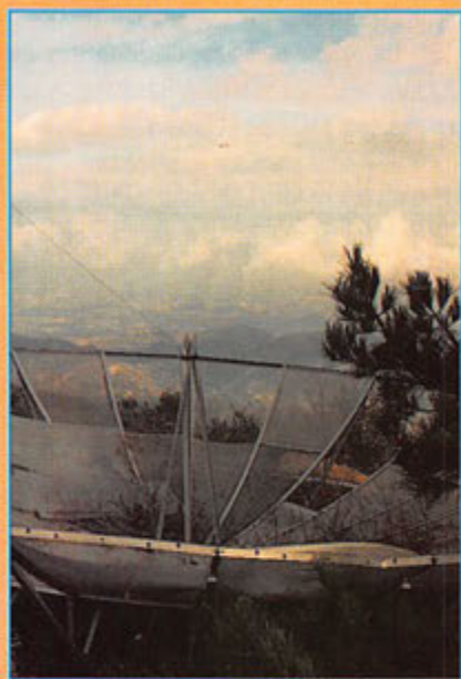
Epave d'une parabole enfoncée par le vent.
