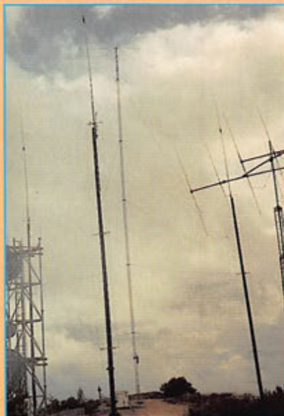
4 él. vertical array pour 160 m.
