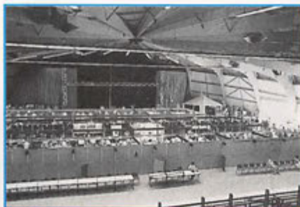
Une vue générale d'Espace 3000.
