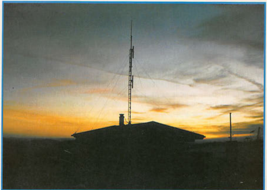
Les antennes sur le toit du chalet
