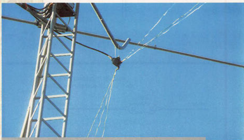
Fixation du multi-dipôle sur un mât.
