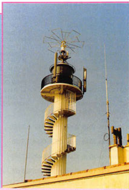
Quelques belles antennes sur l'ancien et le nouveau phare.
