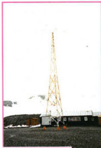
Un beau pylône !
