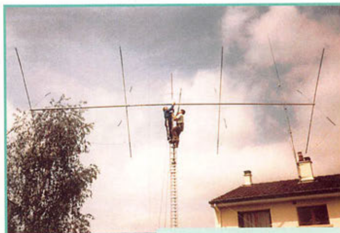
4 éléments quad 21 MHz. Antenne F6DPR, F6DDR.
