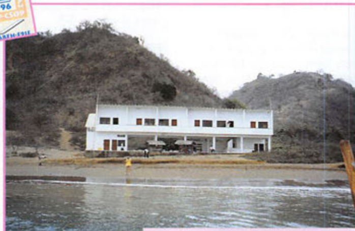
Le bâtiment sur La Plata.
