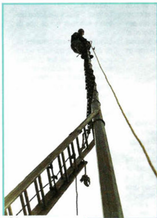
Grimper. Installer les antennes.
