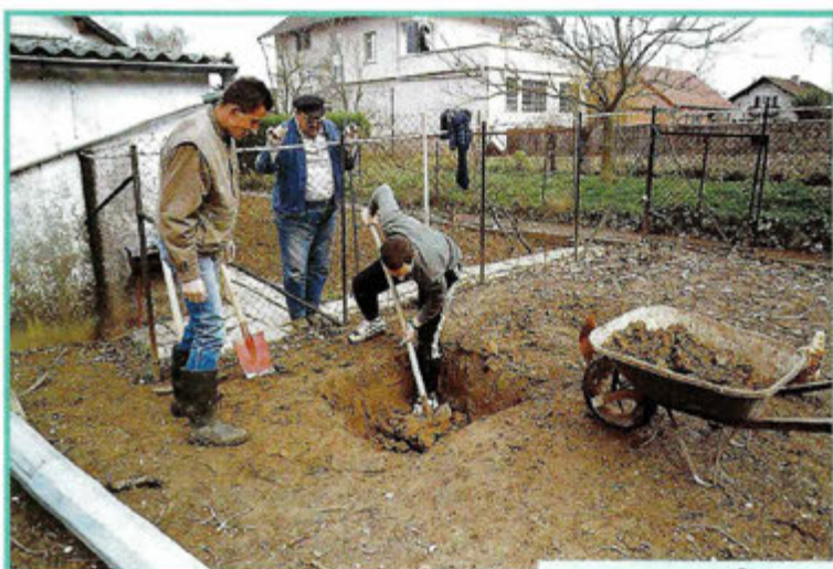
Creuser. Fondations du pylône.
