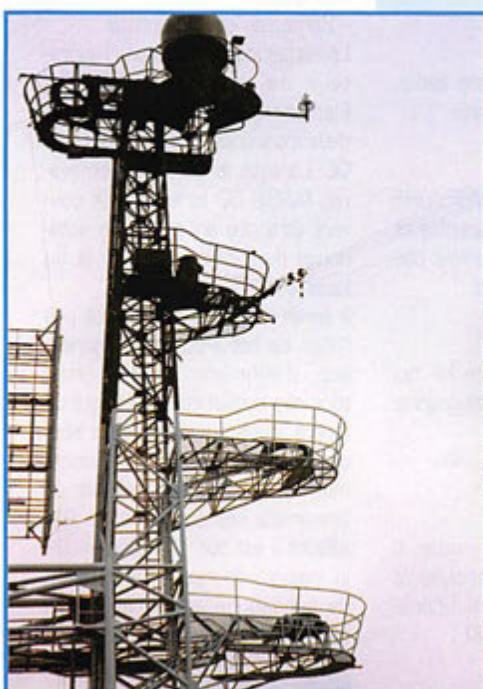
Pylône contre-mesures radar.
