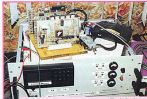
Tiroir logique relais en cours de montage.
