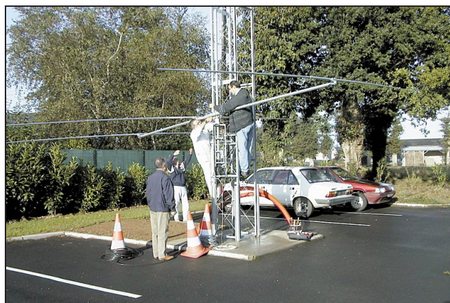
Montage d'une 3 éléments 18 MHz.
