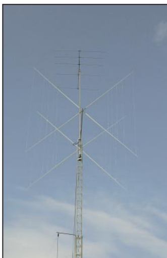
L'antenne cubical quad 2 él. et la 5 él. 50 MHz.
