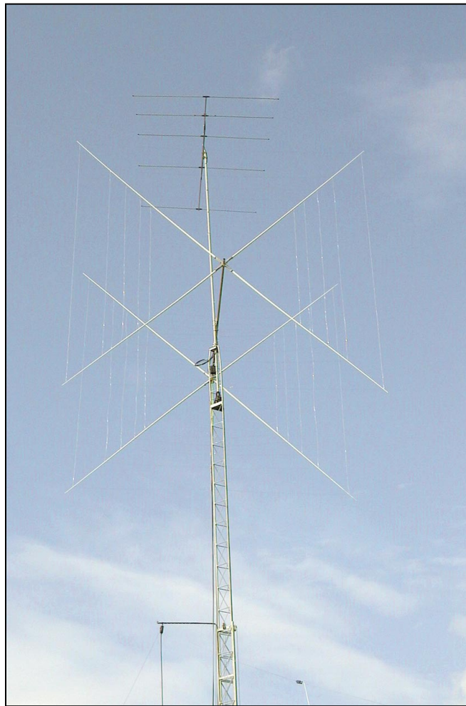
L'antenne montée. En haut, une 5 éléments 50 MHz.
