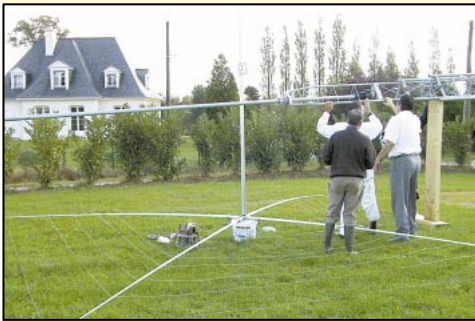
Mise en place face au tube du mât.
