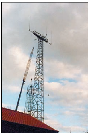
Boulogne : On démonte déjà !
