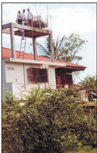
Installation des dipôles sur le toit de la Guest House à Siem Reap.
