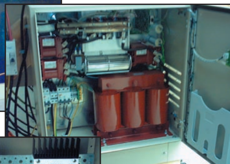
5 et 6 - Le câblage de l'installation.
