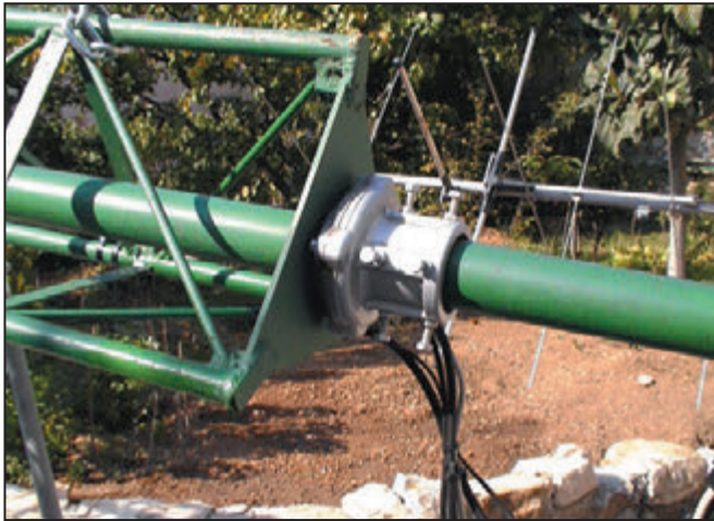
Photo n° 6 : Plaque du support du roulement de mât.
