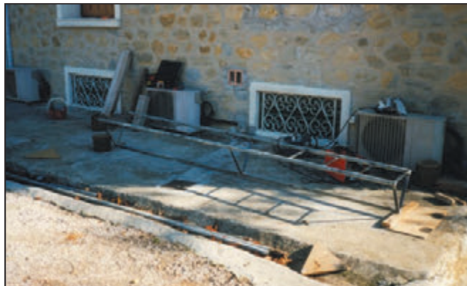
Photo n°1: Tronçon n°2 en cours de fabrication.
