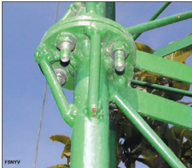
Photo n°2: Exemple de soudage de renfort.
