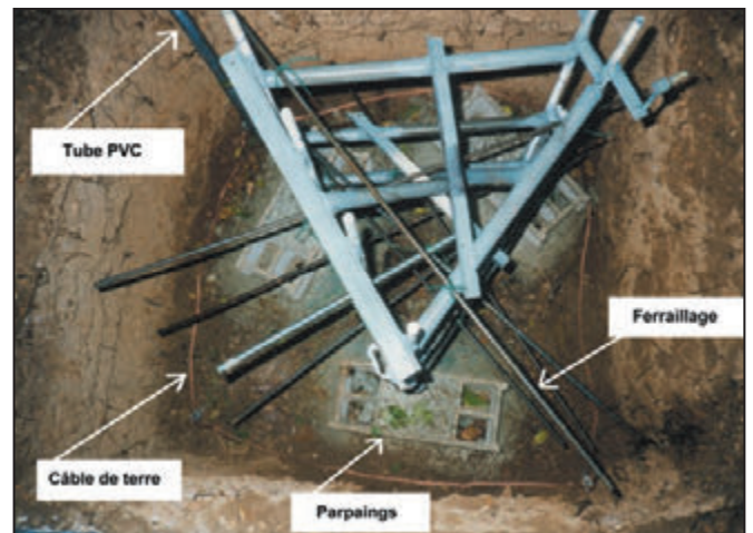
Photo n° 9 : Prise de terre, ferrailage, et réglage de la chaise.
