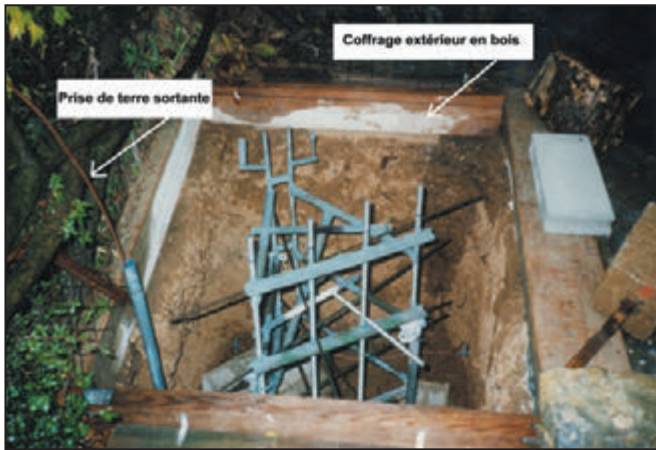
Photo n° 10 : Chaise prête à être coulée.
