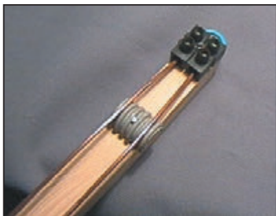
Figure 3: Un support isolant et un domino fixés sur la latte.
