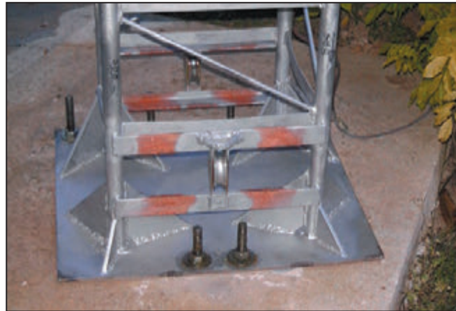
Photos 12 et 13 : Détail du support poulies et treuil sur le contre-pylône.
