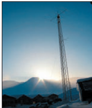
5 - La beam 5 éléments à 30 mètres.
