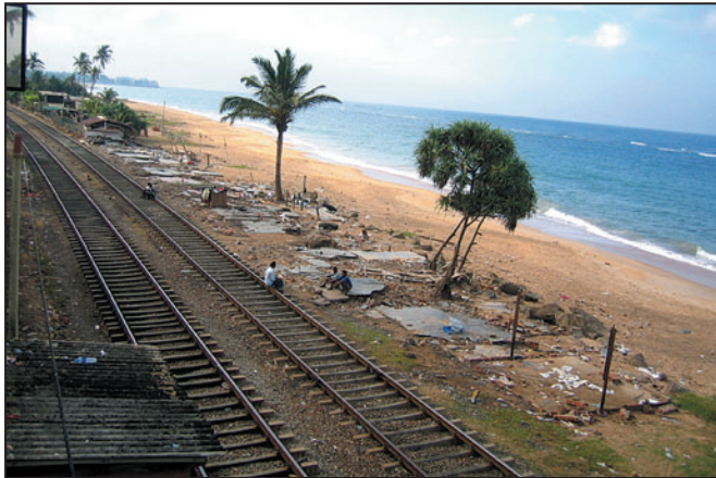
La voie ferrée le long de la côte.
