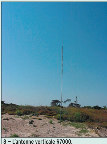
8 - L'antenne verticale R7000.
