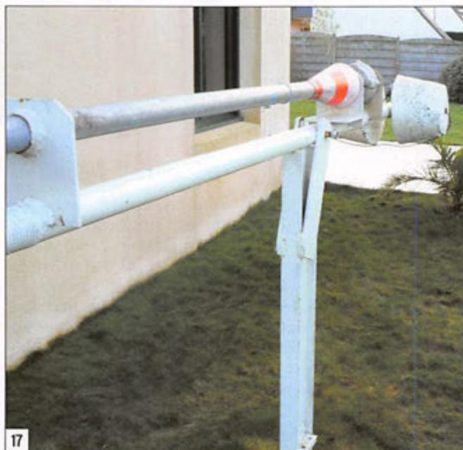
ou des tempêtes. Il faut penser aussi qu'au sol l'antenne doit être très légèrement inclinée pour que l'eau, en suivant le coaxial, ne rentre pas dans les connecteurs des dipôles...
