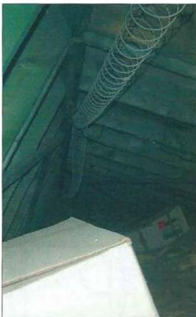
Une Slinky installée sous le toit chez ON4KVV.
