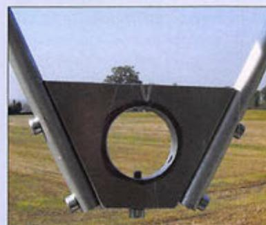
3 - Assemblage triangle et fixation.
