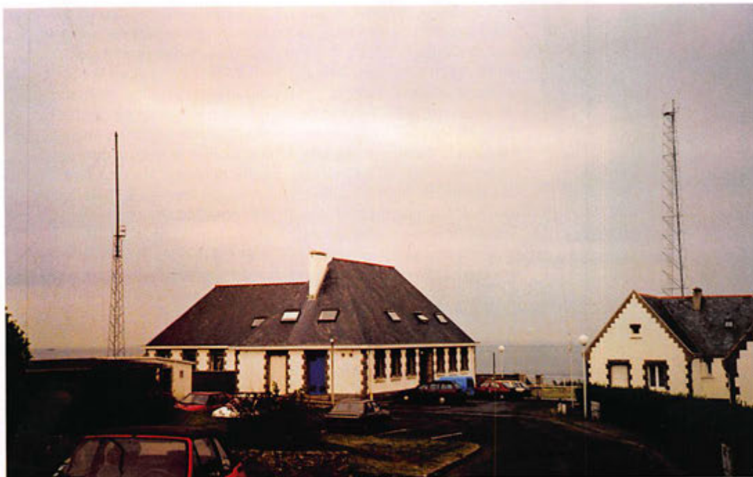
5 - Le Conquet Radio, bâtiment des opérateurs.
