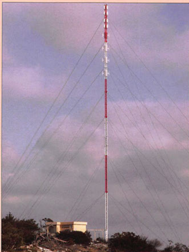
3 - FIR de Marseille. Pylône des antennes de la Ste Baume (alt. 1 000 m).
