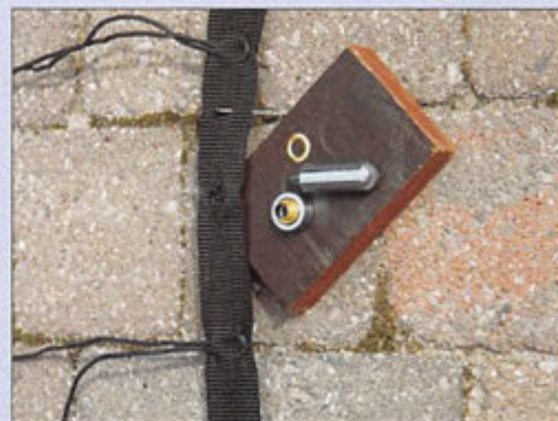
7 - Placement des œillets de fixation au sol.
