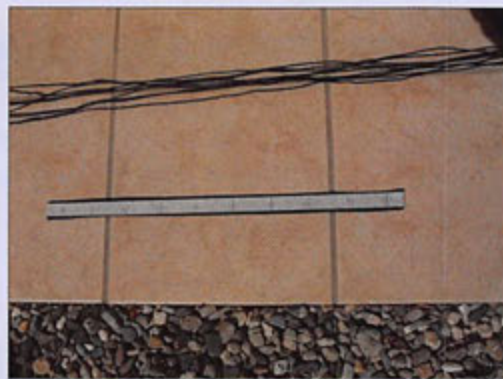
4 - Une bande adhésive pour marquer les perçages.
