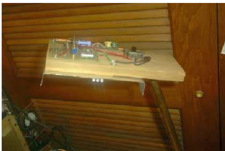
Una lámpara de estación de construcción casera de LED y fluorescente
