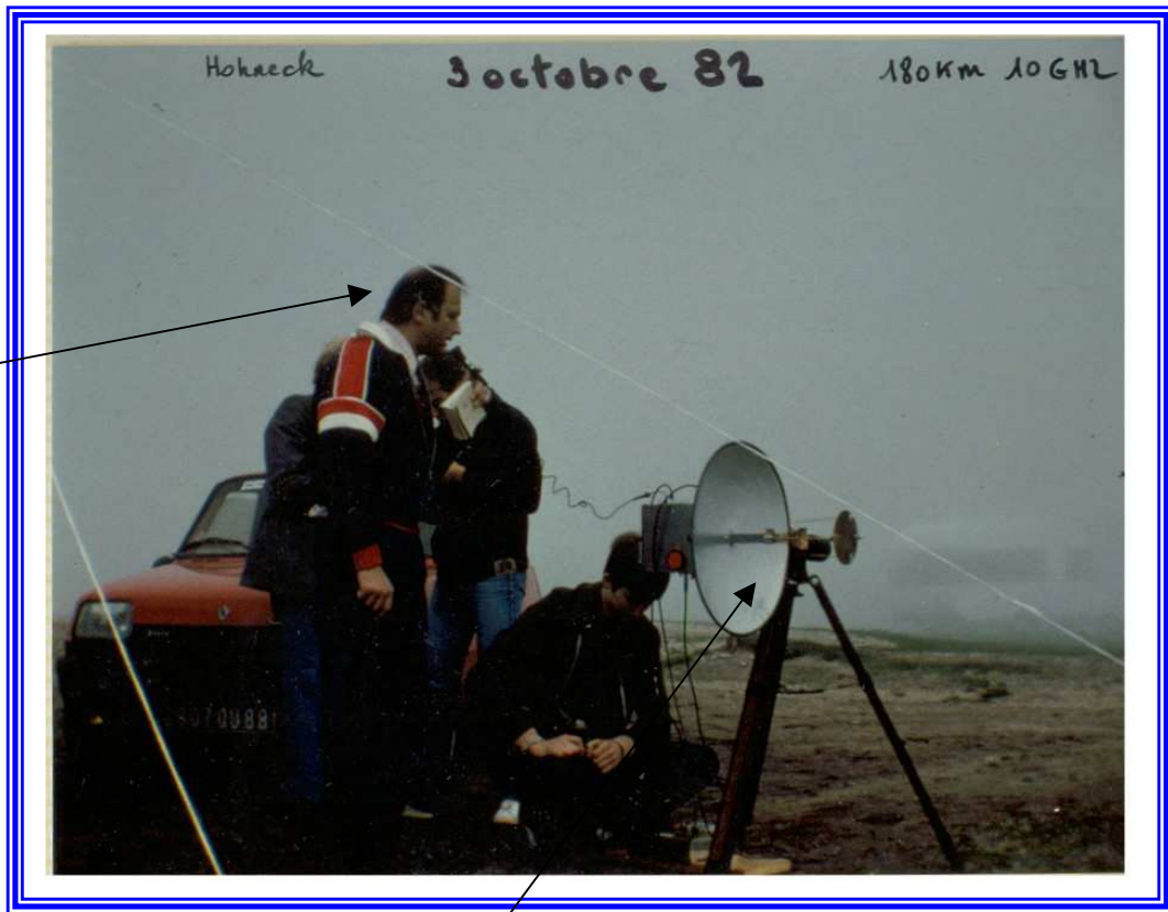
Ensemble très directif, parabole diamètre 40 cm Illumination en indirect par disque, mélangeur à diode Gunn 15 mW liaisons 180 à 200 Km avec HB9MIN
