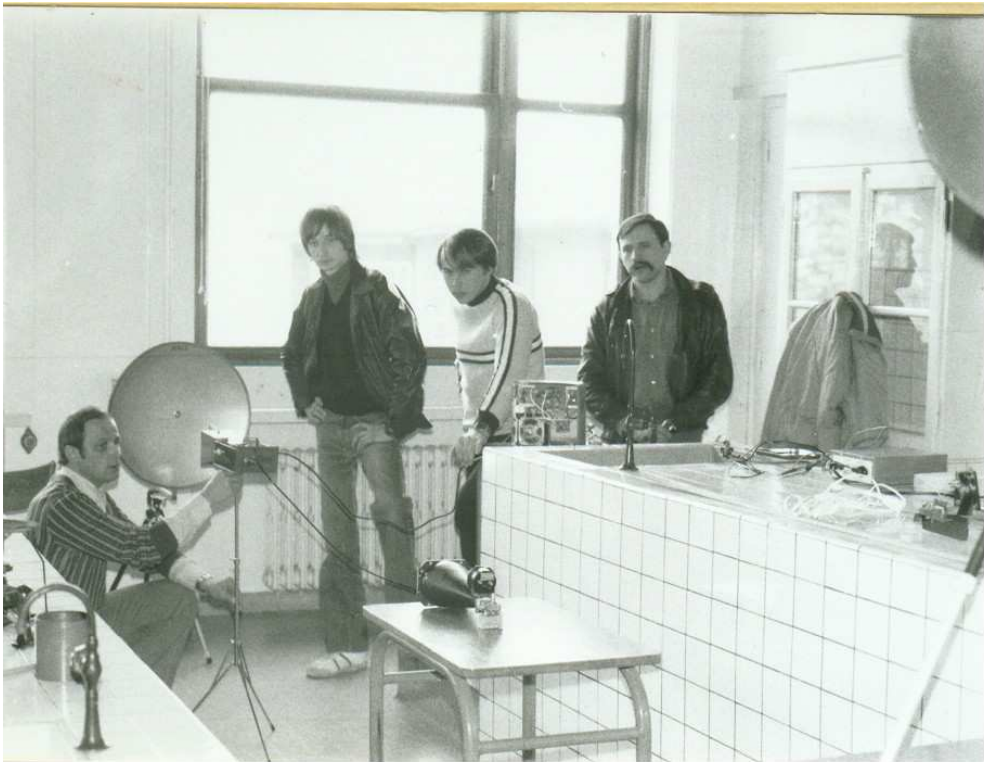
Mesure sur le faisceau émission 10GHZ avec un mesureur de champ, Lycée technique de GERARDMER mars 1981
