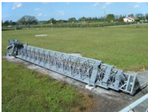
8 - Torre telescópica sendo montada.
