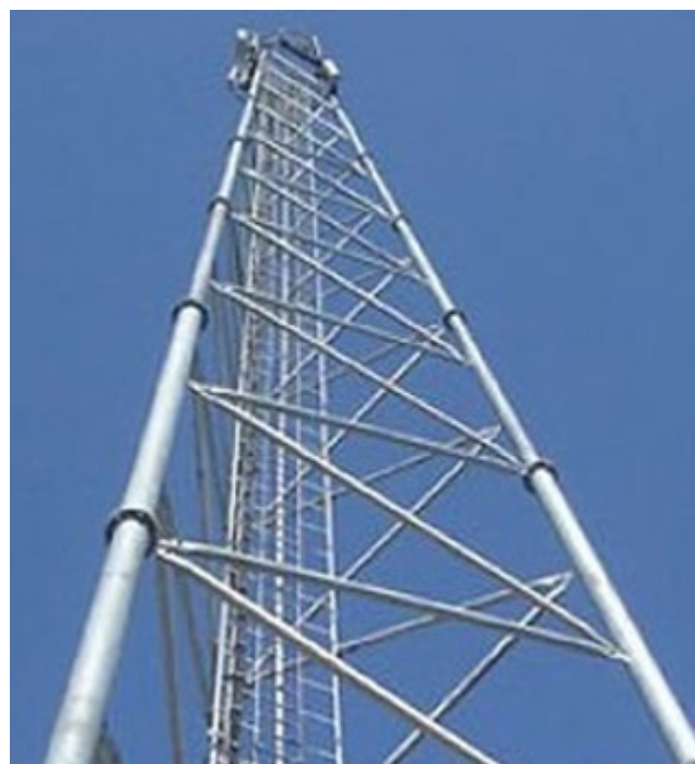
18 - Torre construída com tubos metálicos.
