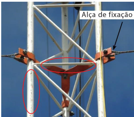
37 - Local de fixação dos estais.
