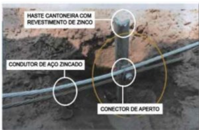
40 - Fotografia de uma haste ligada ao cabo, ambos de aço galvanizado
