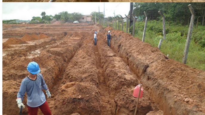
53 - Escavação do solo par execução de malha de aterramento em subestação.
