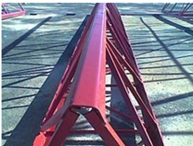
20 - Torre construída com montantes de chapa dobrada e cantoneiras.
