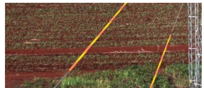
30 - Cabos dos estais com sinalização.
