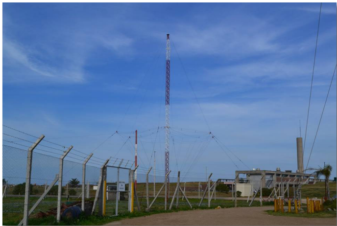
Antena Rômbica da Marinha do Uruguai, essas antenas são caracterizadas por um ganho relativamente alto associado à sua simplicidade.
