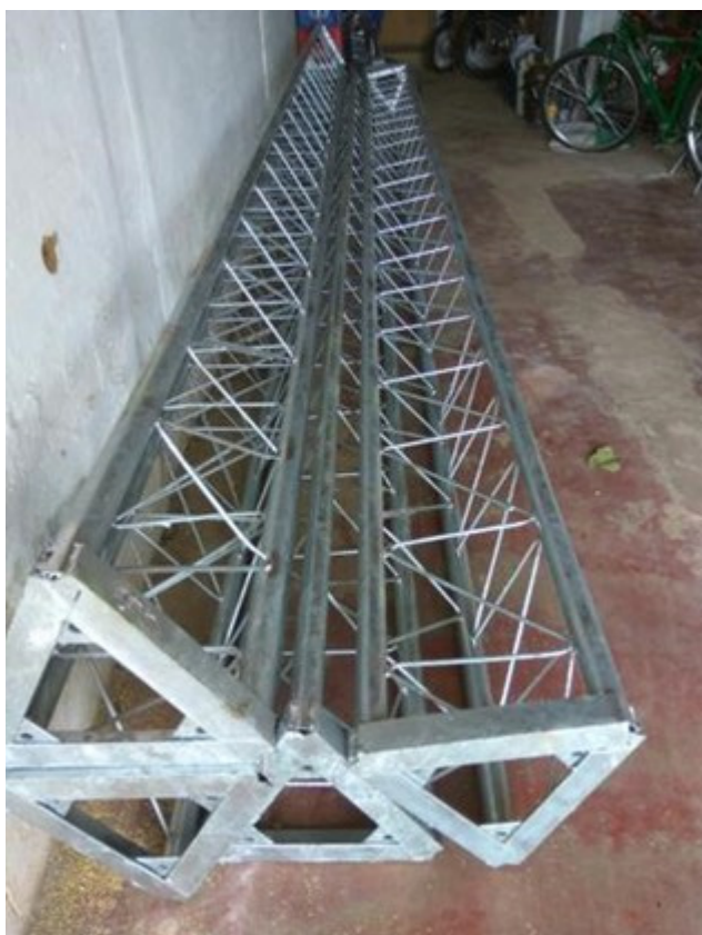
19 - Módulos de torre construídos com tubos e barras redondas.
