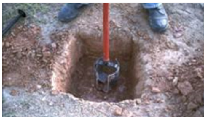
34 – Execução de furo para sondagem
