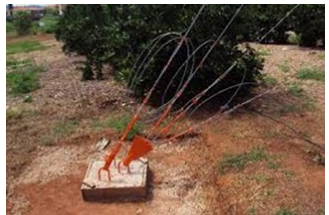
29 - Bloco de ancoragem.
