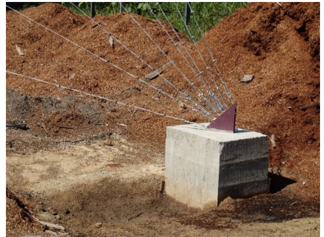
28 - Bloco de ancoragem com 8 estais.
