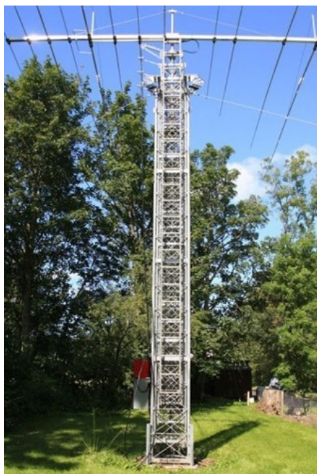
10 - Torre telescópica em posição de ser deslizada.
