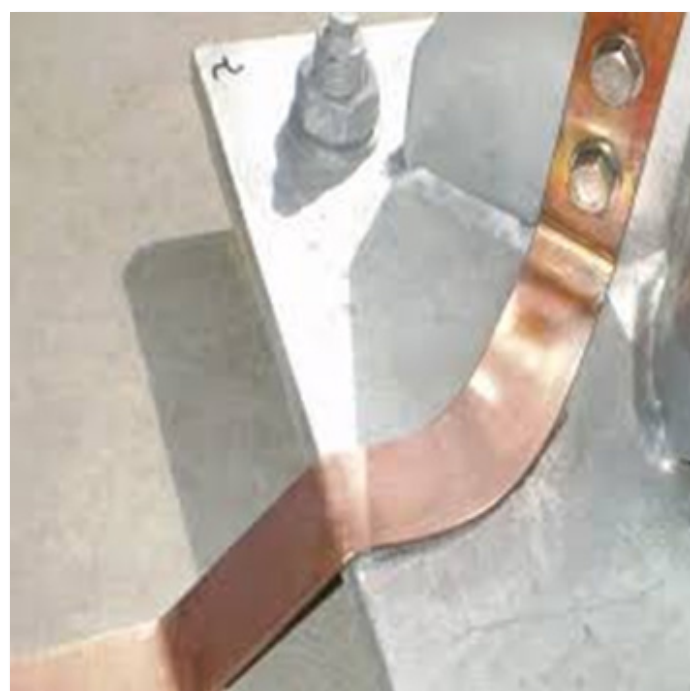
62 – Aterramento da base do mastro
