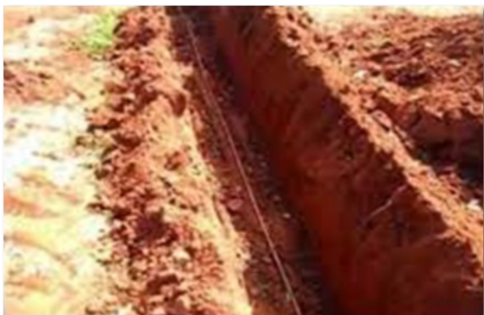
52 - Cabo de cobre em valeta
