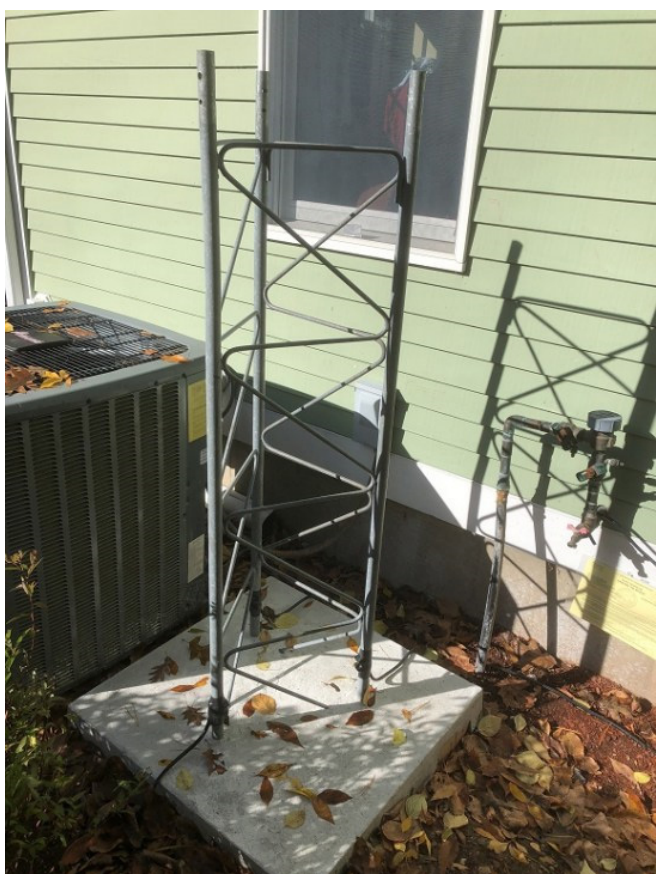
33 - Aterramento do "pé da torre.
