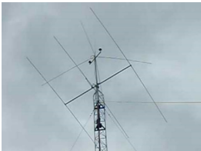
3 - Torre com antenas tipo Yagi e plano terra.
