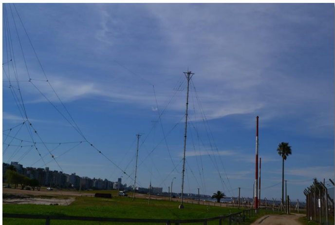
Podemos observar outra formação de antenas rômbicas e um grande mastro, onde um dipolo se cruza horizontalmente e outros em forma de V invertido do mastro principal que se confundem com os tensores do mesmo, pertencentes à Marinha do Uruguai.
