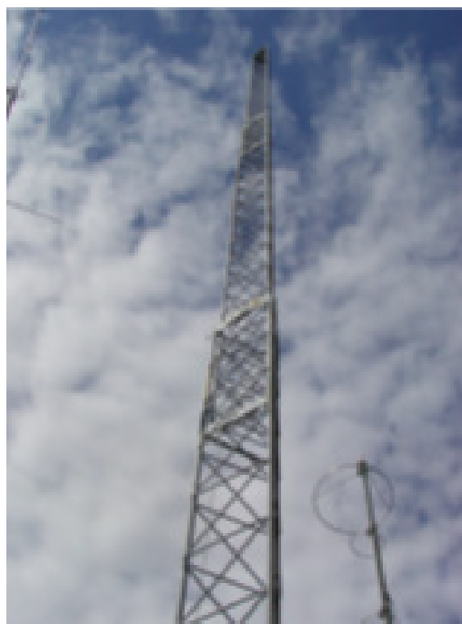
11 - Torre telescópica já erguida.
