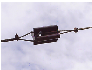
35 - Isoladores de porcelana tipo castanha e modo de amarração.
