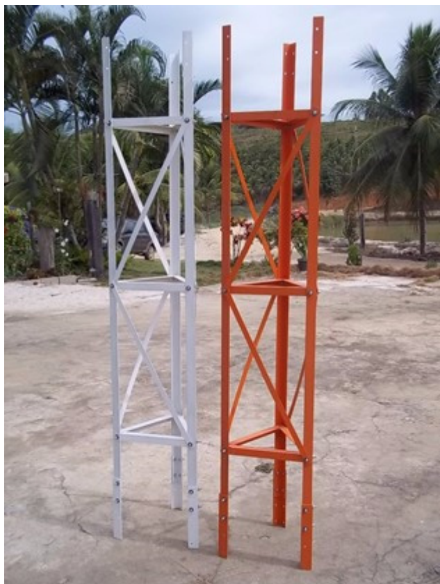
16 – Torre triangular com elementos aparafusados.
