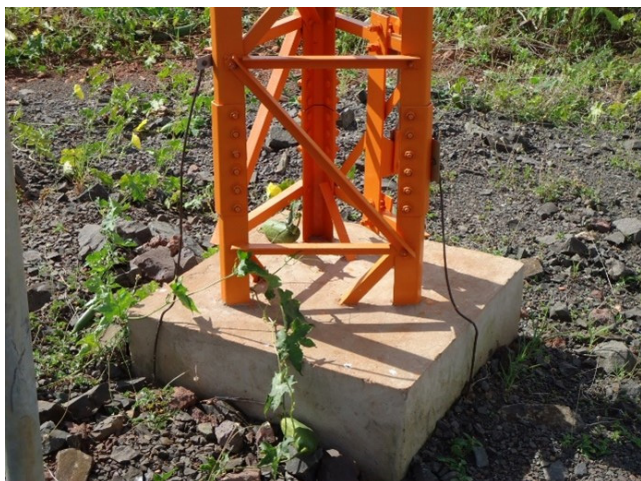
32 - Aterramento do "pé" da torre.
