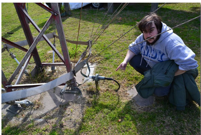
Martin Butera (LU9EFO - PT2ZDX), dentro do campo da antena, mostrando o funcionamento dos cabos coaxiais subterrâneos de uma das antenas.
