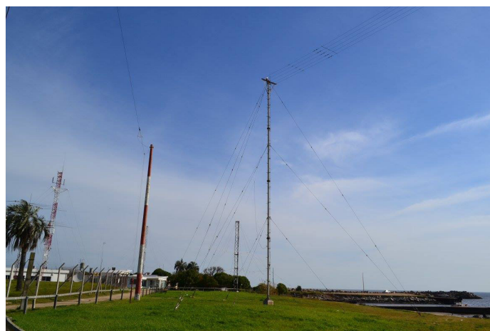
Grande mastro da Marinha do Uruguai, com vários dipolos em paralelo.
