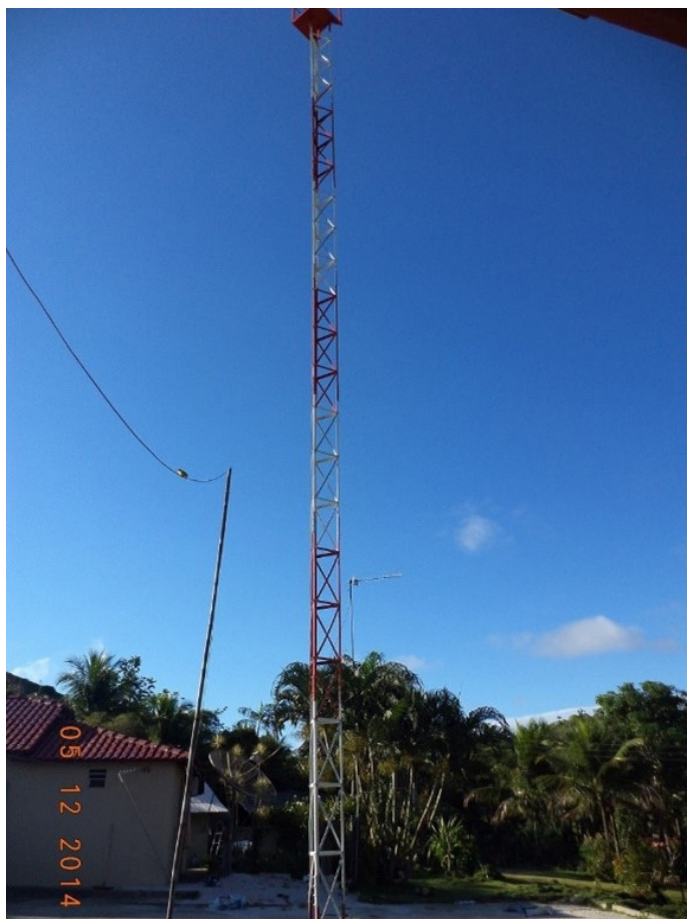
5 - Torre tipo autoportante de formato reto.
