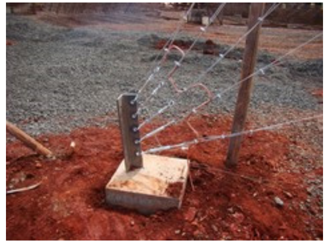
27 - Bloco de ancoragem com 5 estais. Notar o aterramento deles.
