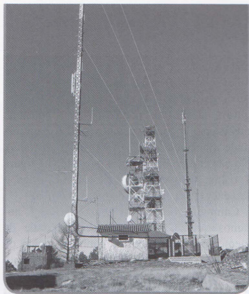
Montagem de antena do CTIEON
