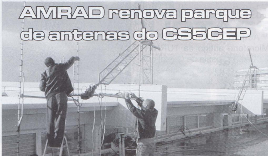
Nas imagens, aspectos do novo parque de antenas, com os trabalhos de instalação de duas novas torres articuladas. São novos sistemas de rotação e elevação das antenas de rastreio de satélites de órbita polar e de novos conjuntos de antenas para as faixas de frequências de 145 e 435 MHz, e ainda para 1.3, 2.4, 5.7, 10 e 24 GHz.
