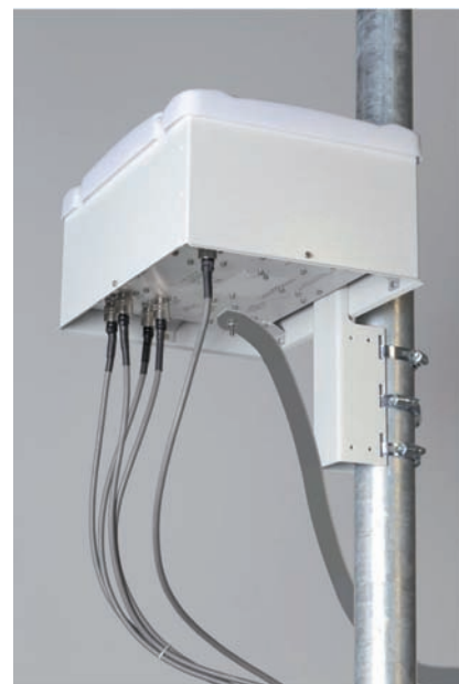
Fig. 9 - 04AT montaggio su mast1.
