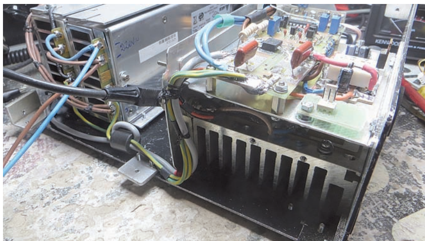
Fig. 10 - Fase di montaggio - Vista frontale.
