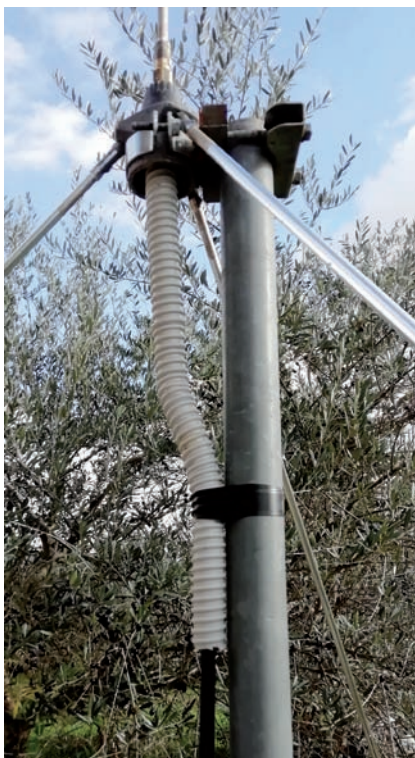
Fig. 13 - Protezione del connettore con la guaina
