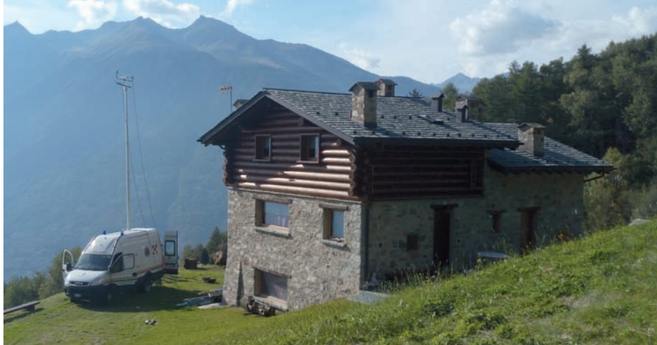
Foto 6 - Centro Trasmissioni Mobile posizionato in quota per dare copertura durante una missione in Valtellina
