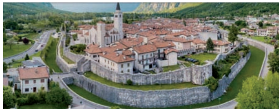
Borgo Venzona (UD) ricostruito (1995!)
