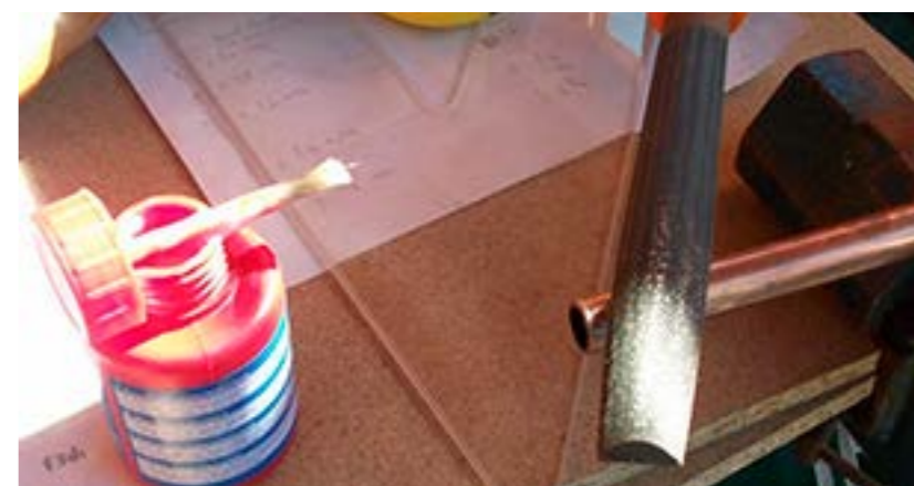
Los tubos marcados con etiquetas adhesivas y listos para su ensamblaje. Para limpiarlos lo mejor es la lima (foto inferior).
