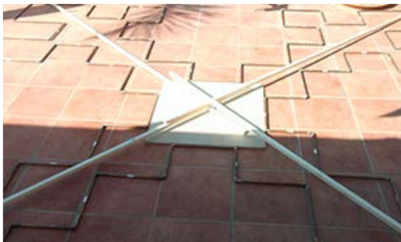
Vista de la estructura central en fibra de vidrio.
