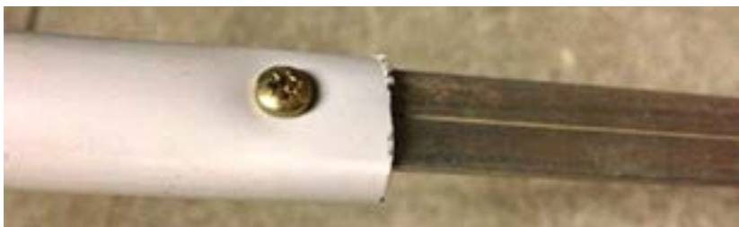
La fijación de cada tubo PVC se hace con un tornillo parker. Abajo, la estructura ya terminada.
