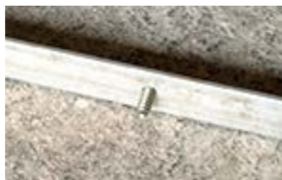
En el centro de cada lado de los cuadrados se coloca un tornillo parker un poco largo para unir el extremo del PVC.
