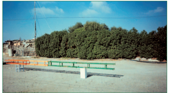
Foto 4: Aspecto de una torre con cuatro cuerpos terminados y ensamblados.
