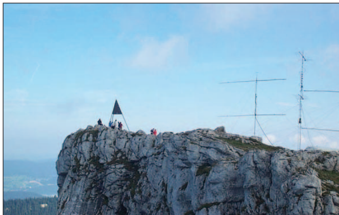
Vista del punto geodésico, en primer plano las 2x13b2 dirección Sur, detrás los dos grupos de 2x17 5WL dirección Inglaterra y Republica Checa respectivamente.
