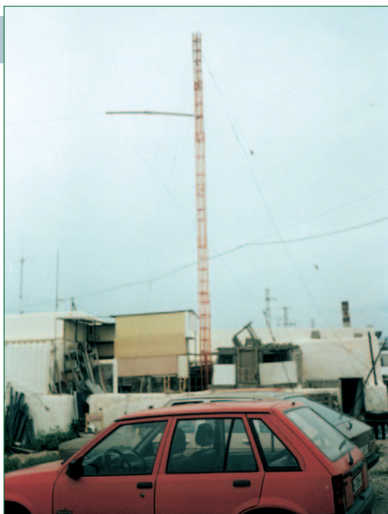
Foto 5: Aspecto de una torre puesta de pie, arriostrada, a falta de instalar sobre la misma los sistemas radiantes. En el penúltimo tramo, tengo instalado un listón telescópico de madera, que me sirve de aislante para la rama de un dipolo.
