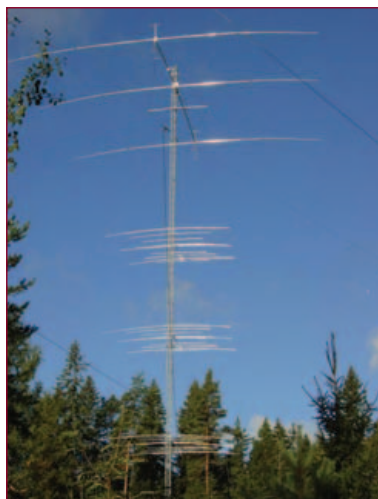
La torre con la yagi para 80 metros fue equipada recientemente con 3 yagis tribandas entrelazadas que proporcional 3-sobre-e-sobre-3 en 15/20 y 4-sobre-4-sobre-4 en 10 metros.
