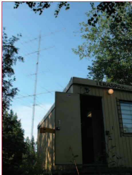
Caseta-shack en lo alto de la colina, cerca de las tres torres. Por detrás se ve la torre de 42 metros que aloja yagis para 20 metros y monobandas para 10 y 15 metros.
