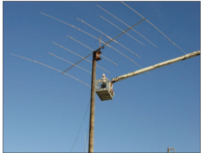
La impresionante tribanda de KJ6BZ se estropeó. OH2PM tuvo que esforzarse bastante para sujetar el cable y colgar una cuerda con la que mover la antena. Encontrar una grúa en buen uso en esta isla del Pacífico no parece difícil.
