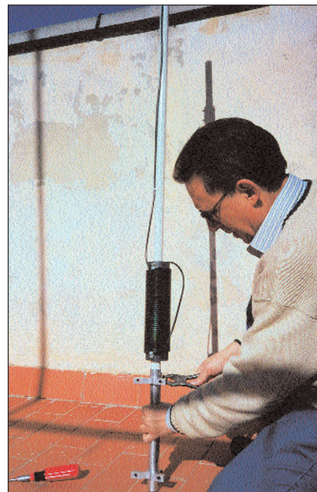
La varilla blanca es de PVC. Abajo, las garras para sujetar la antena al mástil.
