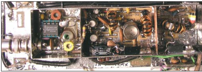
Mezclador TX - Previo TX - Paso final.
