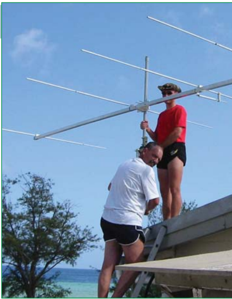
F5NHJ y F5IRO instalando la antena DXSR para 6 m
