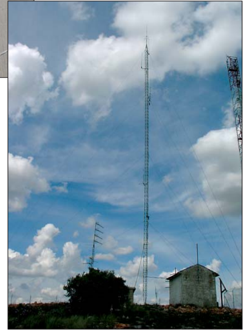
Instalaciones de EA4I
