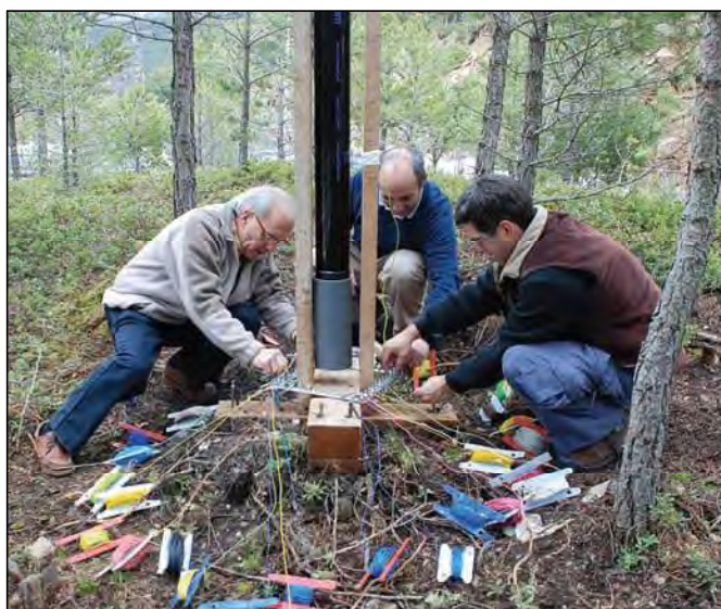
Preparando los radiales en la base de madera autosoportante
