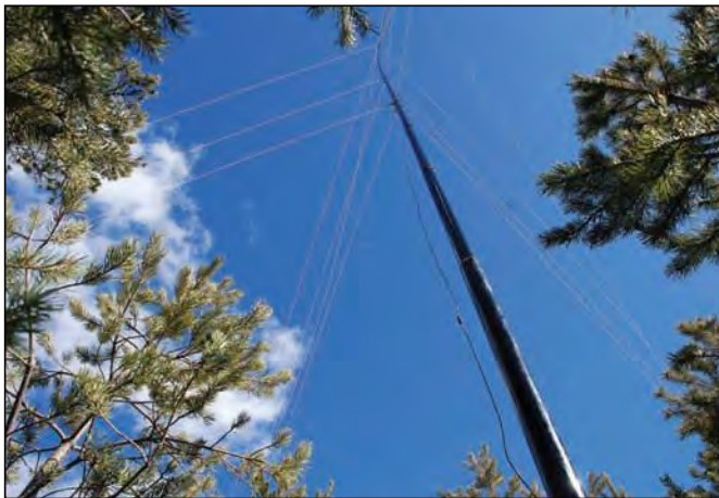
Vista la antena de 160m desde la base
