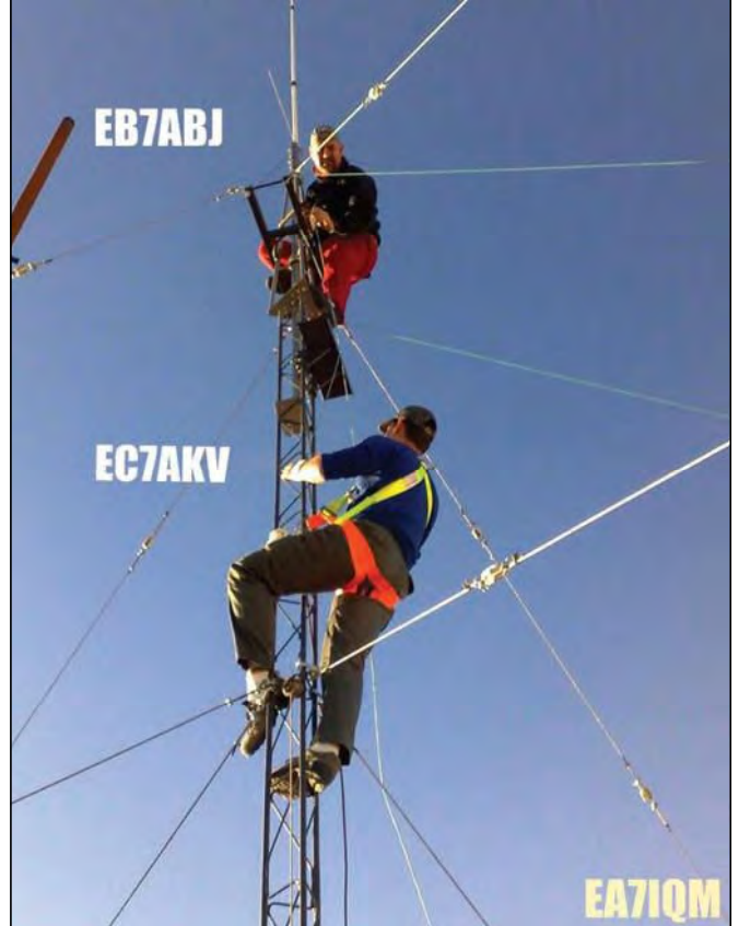
Montaje de la torre
