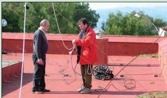
Manolo EA5VH y Salva EA5DY ajustan los tensores del elemento excitado.
