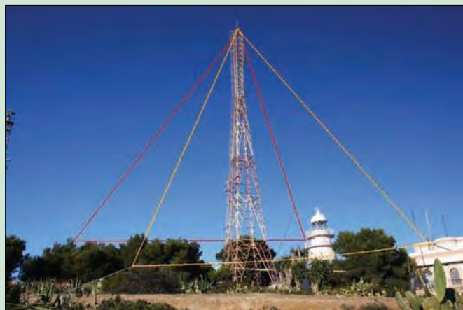
El soporte de la antena de TX es una soberbia torre de 50m junto al faro. El elemento excitado está resaltado en rojo y el reflector en amarillo.
