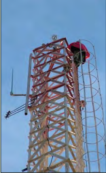
EA5DY, en el vértice de la torre a 50m de altura, instala los soportes de las deltas.
