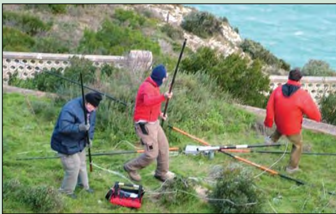
Reparando las antenas de recepción K9AY, destrozadas por el temporal.
