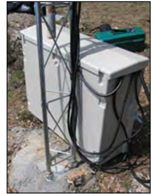
Este es un ejemplo de un nodo de guifi.net alimentado mediante placas solares, ubicado en medio del monte. Son ejemplo de cómo podemos mantener infraestructuras autónomas capaces de ofrecer servicios en casos de emergencias.
