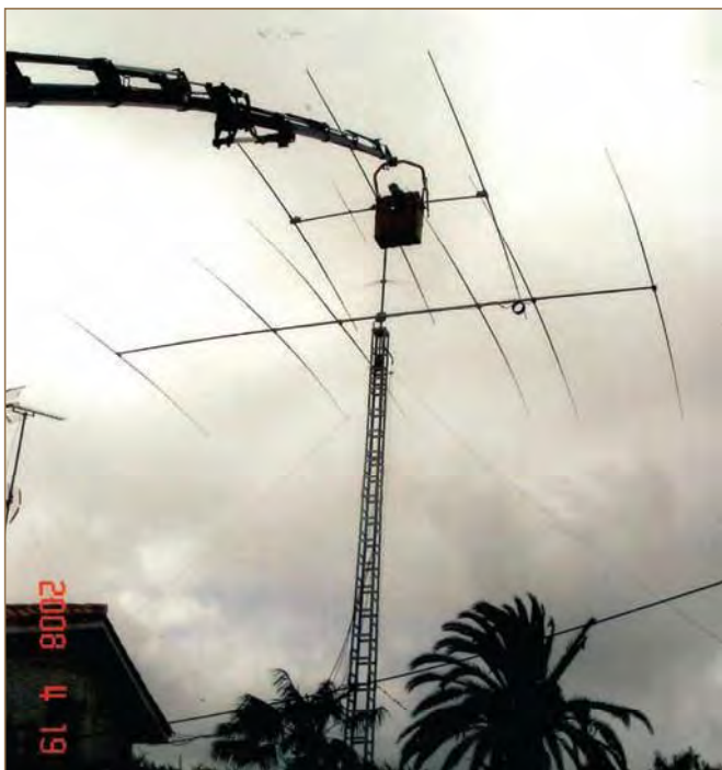
Foto 3. Antena SteppIR de 3 elementos y monobanda de 6 elementos para 20 m. Mástil de 6 metros de acero inoxidable. Longitud 6 metros, 3 pulgadas de diámetro y 0.8 mm de grueso de pared. Espero a prueba de futuros huracanes.
