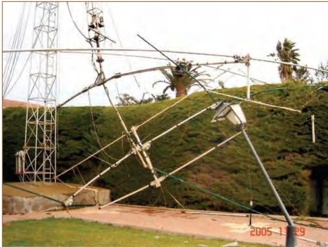
Foto 2. En esta torre estuvo instalada una SteppIR de 3 elementos y yagis Force 12 para 40 y 80 metros.
