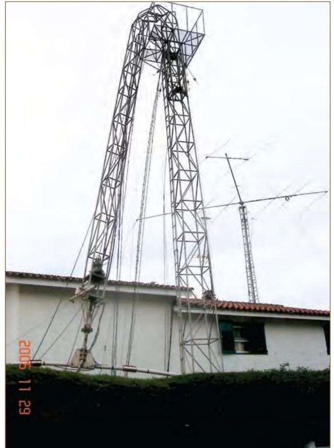
Foto 1. Torres después del huracán. Obsérvese el mástil doblado de la torre que está al fondo.
