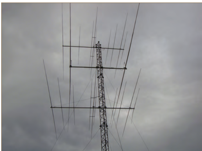
Fotos 3 y 4.- Detalle de las antenas YAGI y de la base de una de las torres.
